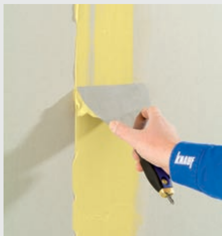
1-я операция: например, шпаклевка КНАУФ Safeboard
